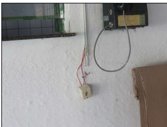
Imagem 07 – Instalações elétricas precárias
