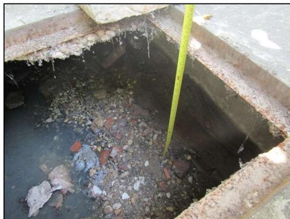
Imagem 16 – Aferição de seção externa do bueiro
