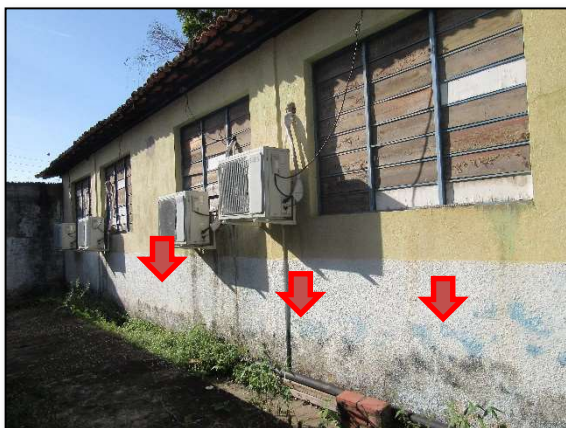
Imagem 14 – Perímetro da escola com manchas de umidade proveniente de alagamentos
