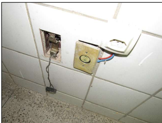
Imagem 07 – Instalações elétricas precárias
