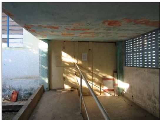
Imagem 23 – Laje apresentando infiltrações e consequentes manchas e descascamento da pintura que encontra-se com seu sistema construtivo degradado por envelhecimento natural
