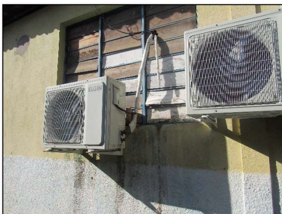
Imagem 10 – Incompatibilização de sistema de esquadrias e instalações
