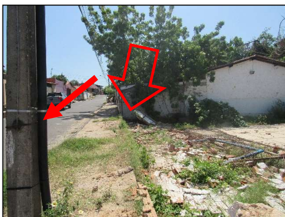
Imagem 03 – Declividade da escola e colapso de muro posterior R. Radialista Benedito de Assis
