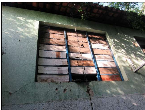
Imagem 09 – Esquadrias impossibilitadas de cumprimento de funções
