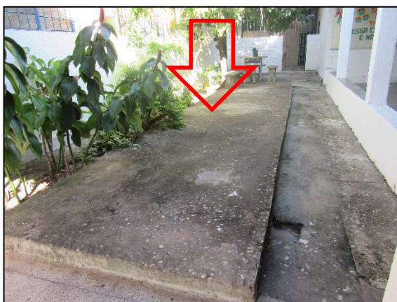
Imagem 12 – Galeria pluvial que passa por dentro da escola
