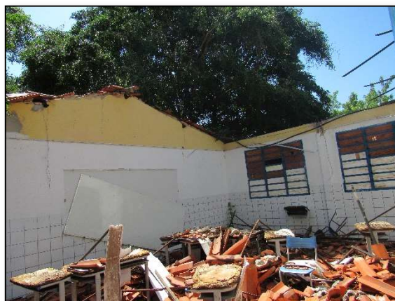
Imagem 19 – Cobertura de unidade escolar colapsada
