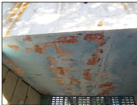
Imagem 23 – Laje apresentando infiltrações e consequentes manchas e descascamento da pintura que encontra-se com seu sistema construtivo degradado por envelhecimento natural
