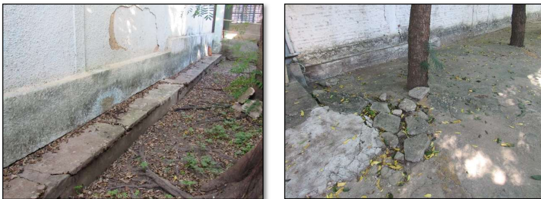
Imagem 20 – Dano a estrutura e deformação em pisos/calçadas provocado pelo crescimento de raízes
