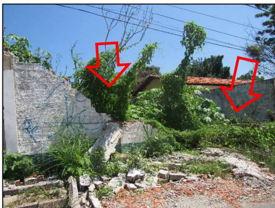
Imagem 05 – Colapso de muro frontal quadra de esportes R. Osima Mendes
