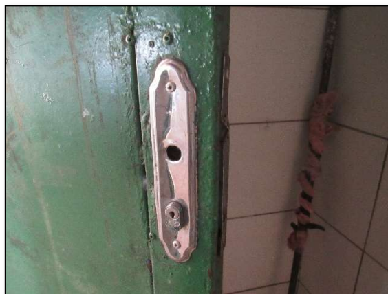
Imagem 09 – Esquadrias impossibilitadas de cumprimento de funções
