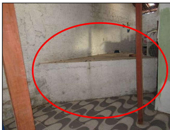
Imagem 12 – Galeria pluvial que passa por dentro da escola
