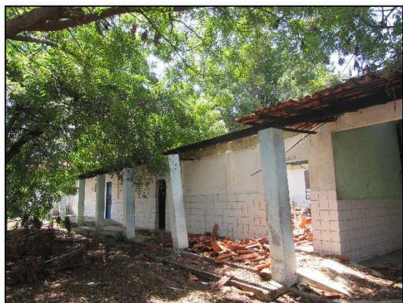
Imagem 19 – Cobertura de unidade escolar colapsada
