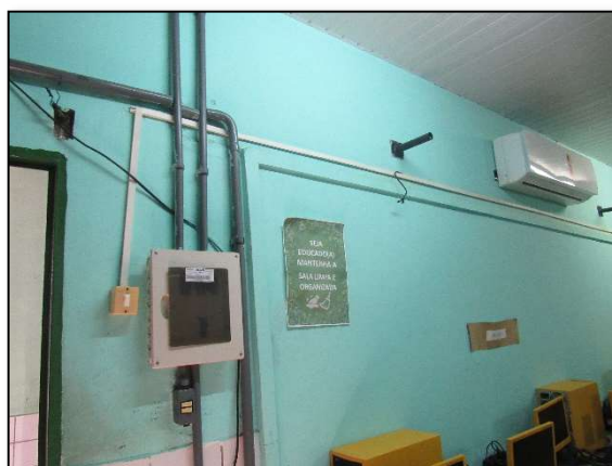
Imagem 07 – Instalações elétricas precárias
