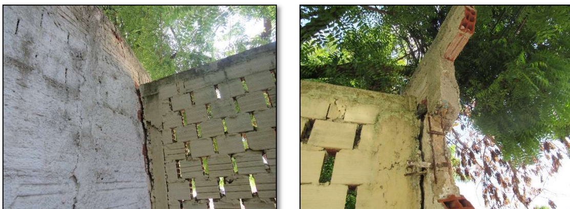
Imagem 21 – Risco eminente de colapso de muro frontal no tocante a ausência de manutenção (poda de arvores)
