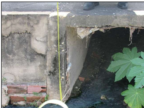
Imagem 16 – Aferição de seção externa do bueiro
