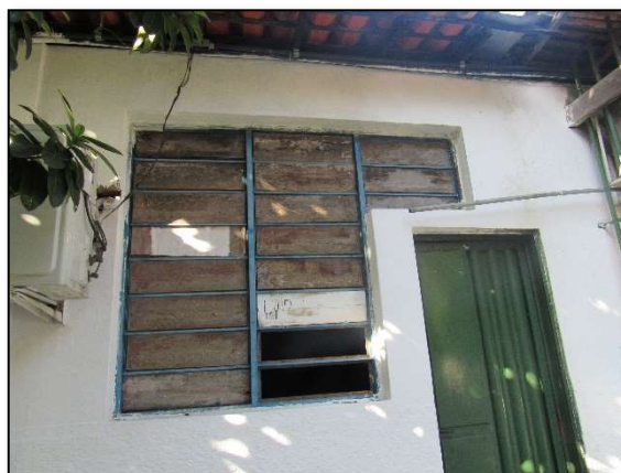
Imagem 10 – Incompatibilização de sistema de esquadrias e instalações
